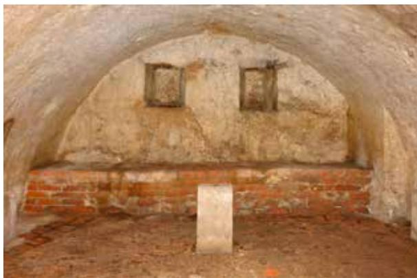
Abb. 8 Kloster St. Marienthal, Kellertonne nach Süden, spätestens um 1683 entstanden (Zustand 2007)
