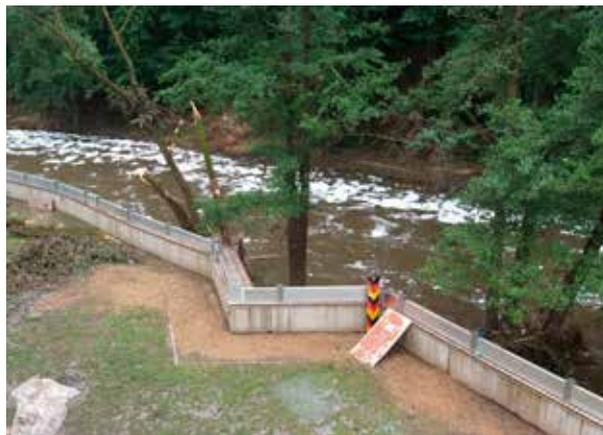
Abb. 20 Umgebender Hochwasserschutz mit aufgebauten, mobilen Elementen, 2010
