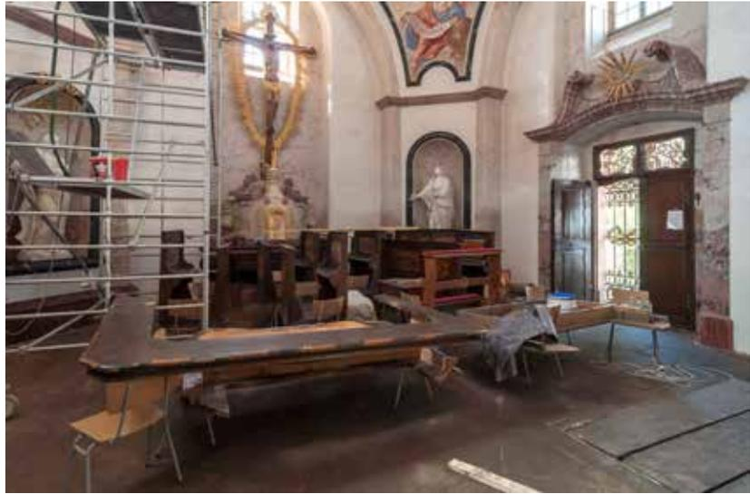
Abb. 25 Michaeliskapelle, Flutwasser-Schäden an den Stuckmarmor-Flächen der Wände August 2010
