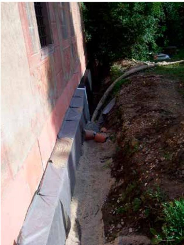
Abb. 3 Drainage gegen aufsteigende Mauerwerksfeuchtigkeit am Gästehaus St. Hedwig
