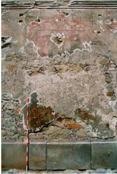
Abb. 16 Illusionistische auf der Ostseite, stark verwittert und vergipst durch langjährige Einwirkung schwefelhaltiger Luft, bedingt durch Wärmekraftwerke in der Umgebung von Ostritz
