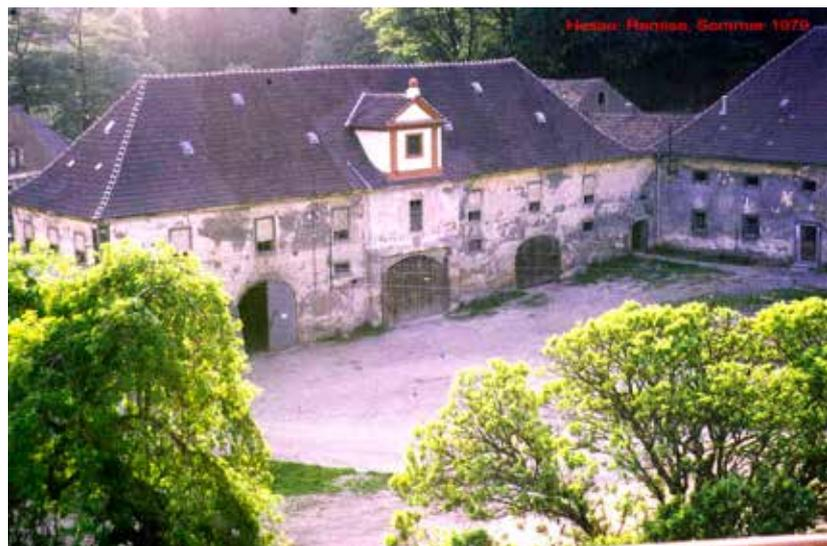
Abb. 15 Blick von Nordost auf die Wagenremise mit frisch verstrichenen Firststeinen und rekonstruiertem Dachhaus, Foto: Hesse, 1979
