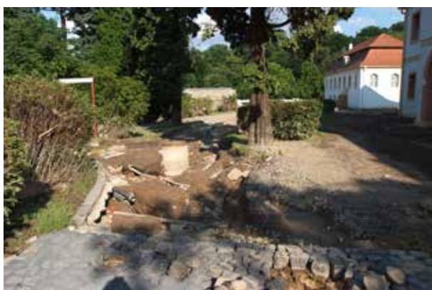
Abb. 21 Durch Hochwasser zerstörte Freiflächen: freigespülte beschädigte Medien und Versorgungseinrichtungen, August 2010
