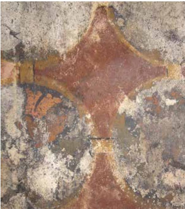
Abb. 39 Abteikirche, Bindemittel-Abbau der Farben durch starke Versalzung, Quellvorgänge und massives Schimmelwachstum, 2013
